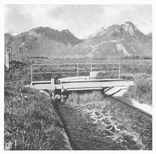
Fig. 4. — Cylindre à cage en marche ou aérateur.
