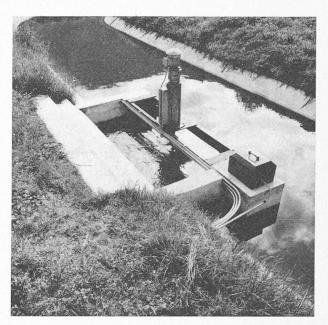
Fig. 5. — Le déversoir et la boîte à électrodes.
