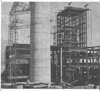
Charpente métallique d'une des 2 chaudières monotubulaires Suízer en montage à la Centrale thermique de Chavalon
