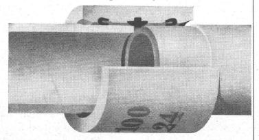
Le joint Triplex a été créé pour le raccord de tuyaux à pression en amiante-ciment: un manchon comprenant trois bagues de caoutchouc assure une pose et un montage rapides et faciles. Les conduites en tuyaux d'amiante-ciment peuvent être posées dans des fosses mouillées avec un outillage simple.
