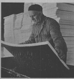
Les plaques «Styrofoam» se coupent facilement – et se rompent proprement en les taillant. Posé dans le coffrage, «Styrofoam» est une isolation sûre qui n'absorbe pas d'humidité et qui reste neutre. «Styrofoam» peut être posé à l'aide de mortier ou colle et crépi directement. Pour les isolations de chambres frigorifiques «Styrofoam» est généralement posé à l'aide de bitume chaud. «Styrofoam» est très léger et facile
