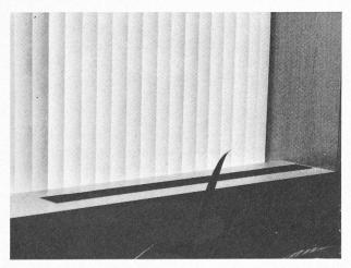
Fig. 3. — Grille de pulsion d'une installation de climatisation à haute pression et persiennes à lamelles verticales « Protecta-Sol ».
