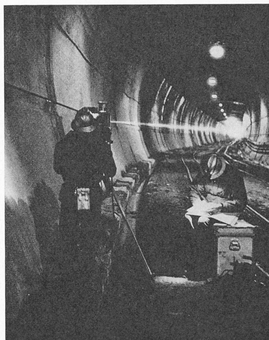
Fig. 3. — Télémètre à ondes lumineuses.
