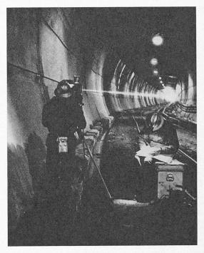
Fig. 3. — Télémètre à ondes lumineuses.
