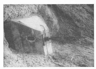
Fig. 4. — Bloc d'appui d'un tirant.
