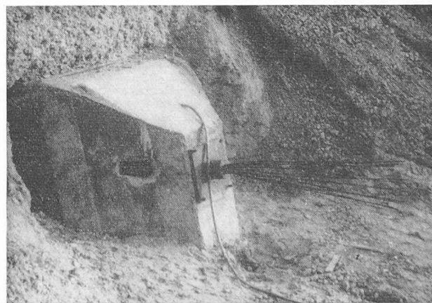
Fig. 4. — Bloc d'appui d'un tirant.
