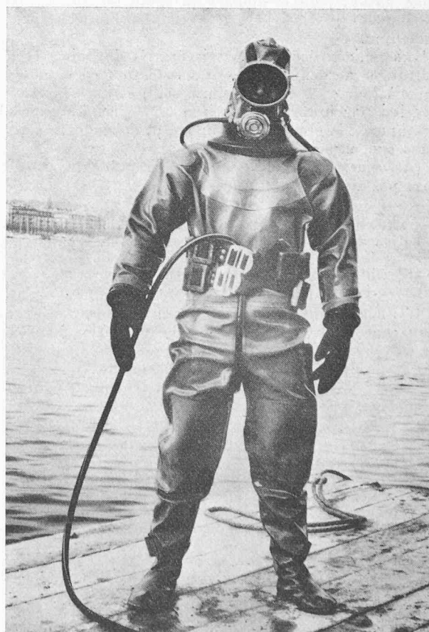
Fig. 13. — Plongeur équipé d'un vêtement étanche à volume constant utilisé dans les eaux froides ou polluées. Alimentation en air basse pression par narguilé relié au compresseur de surface.
