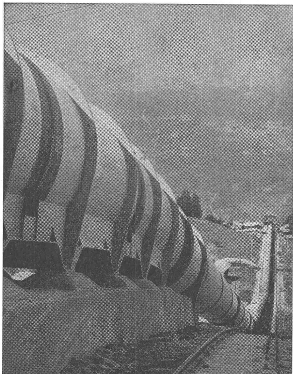
Conduite forcée en plein air de Nendaz de la Grande Dixence S. A., en montage. — Diamètre 3150 mm. Pression maximum d'essai en atelier 84 atm.
