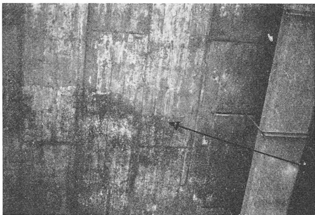
Fig. 18. — Variation de teinte résultant de l'emploi de produits retardant la prise.
