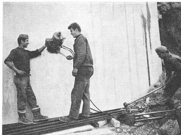
Fig. 2. — Mise en tension des ancrages en alluvions.
