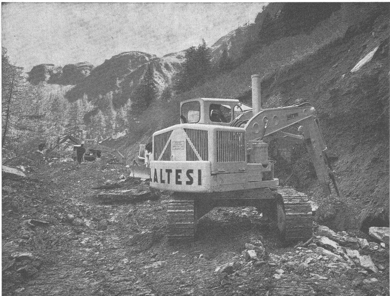
En observant les travaux d'installation du pipeline dans la section montagneuse du Splügen, vous pouvez constater l'avancement rapide du creusement de la tranchée.
