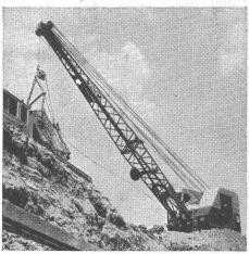
«Lors des travaux de terrassement d'un passage inférieur de l'autoroute au Mont s/Lausanne une 30-RB et deux dumpers étaient en service. Nous avons déblayé 1500 m³ en 9 h 1/2», déclare Toni Nussbaum, conducteur d'une 30-RB.
