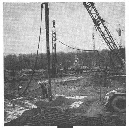
Compactage en profondeur selon le procédé RDW pour réduire la perméabilité de plusieurs bassins de décantation.
