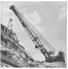
«Lors des travaux de terrassement d'un passage inférieur de l'autoroute au Mont s/Lausanne une 30-RB et deux dumpers étaient en service. Nous avons déblayé 1500 m³ en 9 h ½», déclare Toni Nussbaum, conducteur d'une 30-RB.
