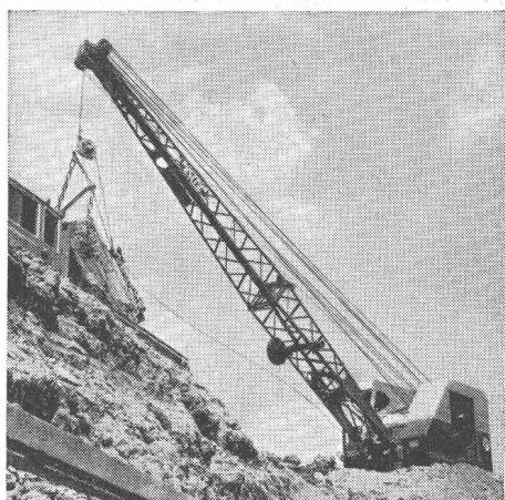
«Lors des travaux de terrassement d'un passage inférieur de l'autoroute au Mont s/Lausanne une 30-RB et deux dumpers étaient en service. Nous avons déblayé 1500 m<sup>3</sup> en 9 h 1/2», déclare Toni Nussbaum, conducteur d'une 30-RB.
