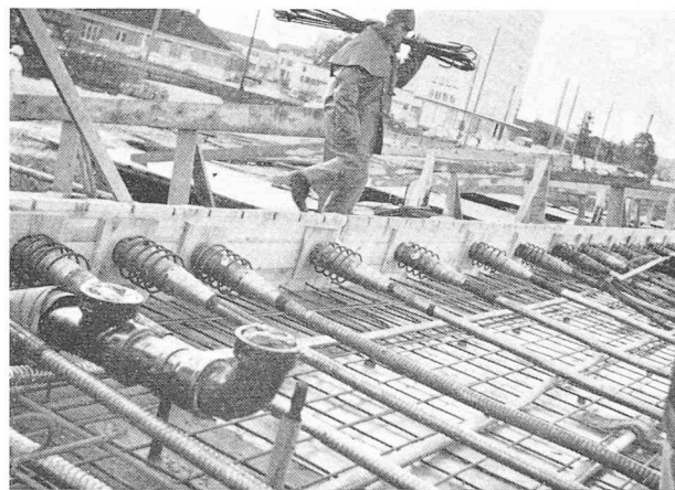
Fig. 2. — Têtes des câbles de l'entrepôt avant la pose de l'armature morte supérieure et le frettage des têtes.
