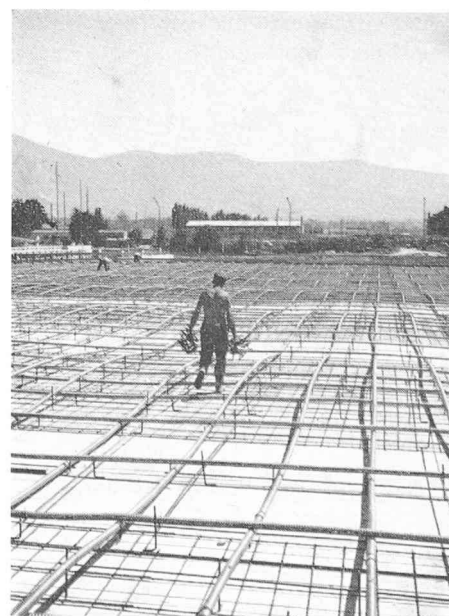
Fig. 3. — La mise en place des câbles de précontrainte du garage (dimensions d'une dalle : 60 x 60 m).
