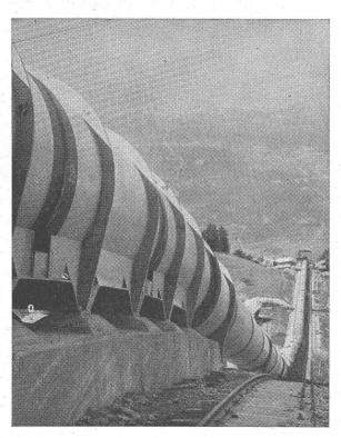
Conduite forcée en plein air de Nendaz de la Grande Dixence S. A., en montage. — Diamètre 3150 mm. Pression maximum d'essai en ateller 84 atm.
