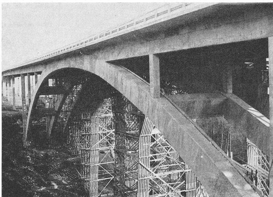
Fig. 3. — Détail du tronçon sur arcs nord (l'effet de perspective raccourcit et déforme l'arc).
