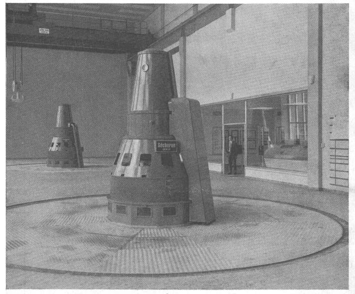
2 alternateurs synchrones triphasés à axe vertical 42 MVA, 214 t/min , 10 kV avec leur équipement complet d'excitation et de réglage.
