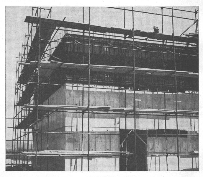
Image: Coffrage grimpant et échafaudage à cadres-H-ACROW pour la centrale thermique des nouvelles usines Ed. Dubied & Cie S. A. Marin (NE)
