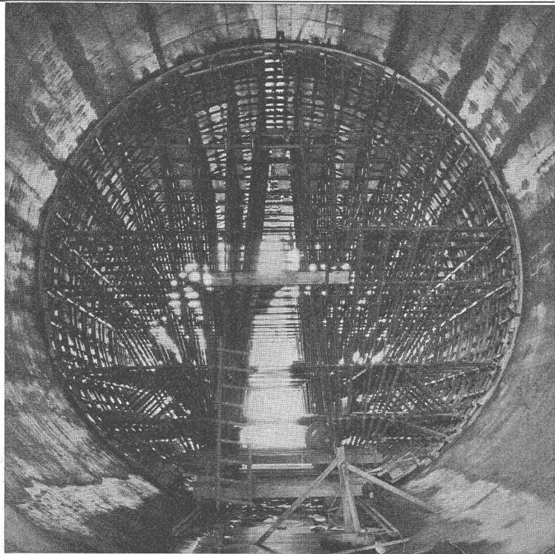
Photo : Galerie d'aménée à pression de l'usine hydro-électrique Reichenau.
