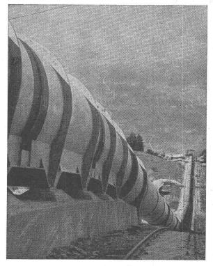
Conduite forcée en plein air de Nendaz de la Grande Dixence S. A., en montage. — Diamètre 3150 mm. Pression maximum d'essai en atelier 84 atm.
