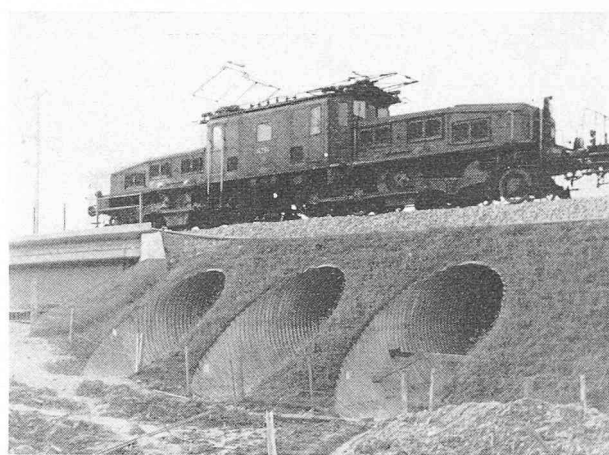
Fig. 17. — Le remblai allégé. (Photo Bureau des autoroutes)
