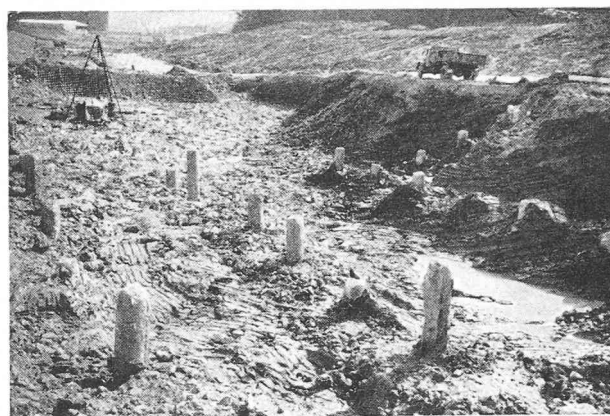
Fig. 7. — Forages dans les pieux.
