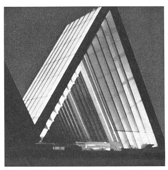
Fig. 41. — Elément du Secteur 1, « Partie générale ». C'est une structure en bois recouverte d'une toile plastique dissus de 38 % de facteur de transparence. Dans ce cas, l'élément est éclairé de l'intérieur par un projecteur pour lampe à iode de 1000 W. Il est à remarquer les innombrables possibilités de jeux d'ombre et de lumière simplement par l'emplacement de la source lumineuse.
