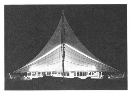
Fig. 42. — Tente de restaurant dans le secteur du port. Eclairage de la partie inférieure (foc) de l'intérieur par une rangée de tubes fluorescents placés audessus des vitrages. Il est prévu en plus l'éclairage des focs par deux projecteurs extérieurs placés sur le mât visible sur la photo.
