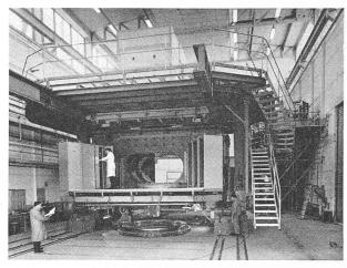
Montage de la chambre à bulles à hydrogène de 2 m du CERN, dans le bâtiment spécialement construit pour son utilisation.
