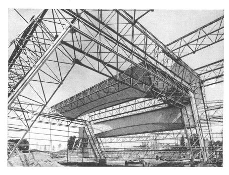
Fig. 28. — Halle prototype pour l'essai de fermeture des pignons et de couverture.
