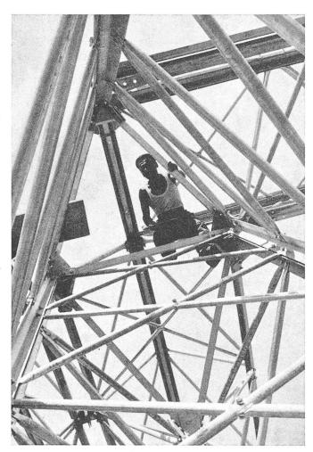
Fig. 34. — Vue intérieure d'un angle d'un cadre montrant les particularités d'attache des diagonales et du contreventement aux membrures.
