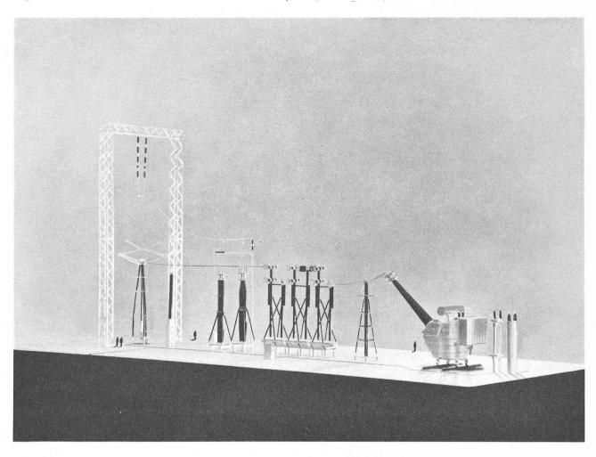
cordé une protection électronique de distance qui déclenche toute l'installation dans un temps très court en cas de défaut ou lors des essais prévus d'élimination d'un arc volontairement provoqué.
