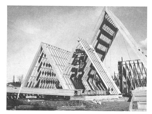
Fig. 17. — Montage au sol d'une paroi entière de prismes que l'on fera ensuite pivoter; à droite de la paroi, on distingue la banquette en béton continue avec les pièces d'appui.
