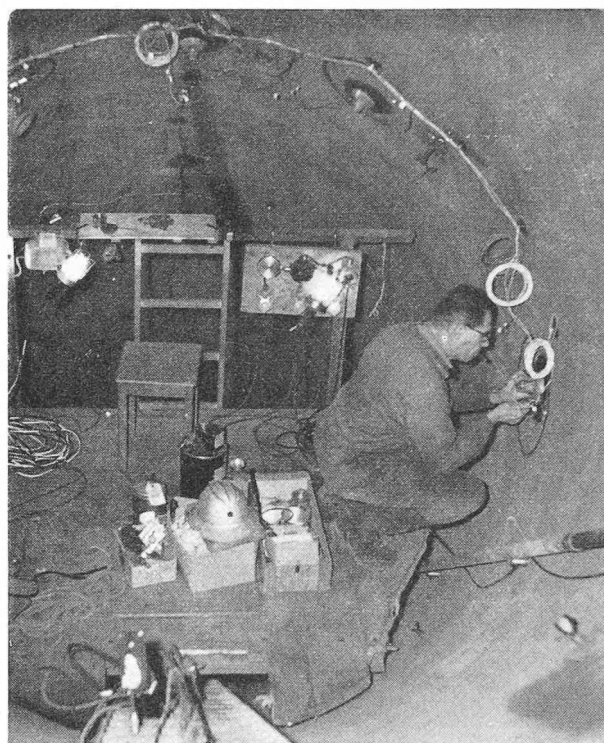
Fig. 5. — Mise en place des jauges de contrainte.
