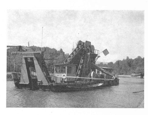
Fig. 14. Grande drague flottante, avec godets de 150 litres.
