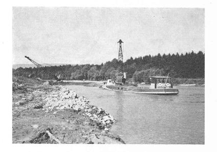
Fig. 13. Excavations au moyen de draglines. Le dragline à gauche de la photographie enlève 'la terre végétale et l'entrepose au bord du canal.
