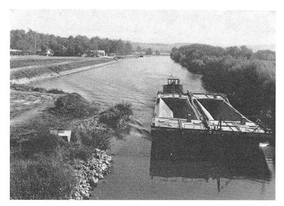
Fig. 16. — Convoi poussé pour transport des excavations du canal de la Broye. Au premier plan, le canal actuel; en arrière, le canal approfondi et élargi.
