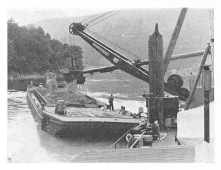
Fig. 20. — Le Manitowoc remplissant un bateau à clapet d'une capacité de 300 m³ à l'entrée du canal de Nidau à Büren.
