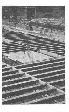
Pour coffrage de dalles tout à fait plane Langues d'appui rétractables Dessus très large Réglage facile Robuste
