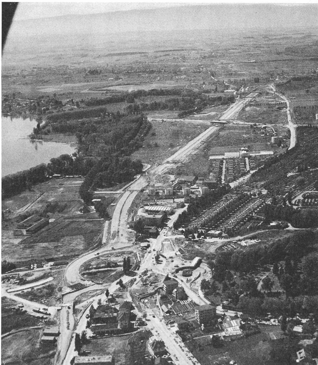
Fig. 4. — Le giratoire de la Maladière en chantier. Photo Y. Debraine.
