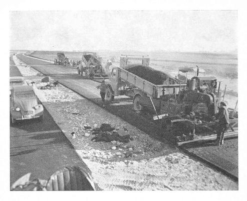
Fig. 5. — Pose de la couche de support HMT en enrobés hydrocarbonés.
