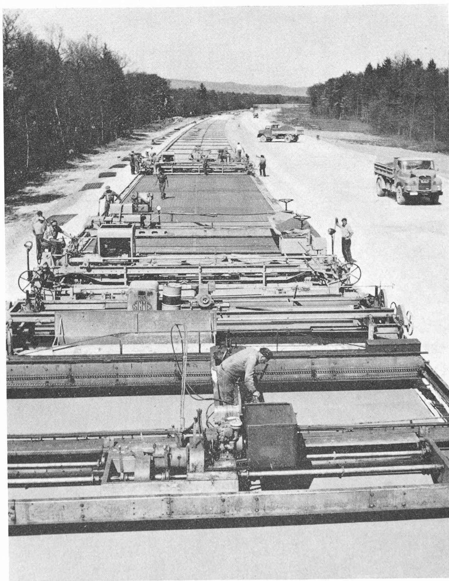
Fig. 16. — Au premier plan, la finisseuse longitudinale, puis toutes les autres machines du train de bétonnage.
