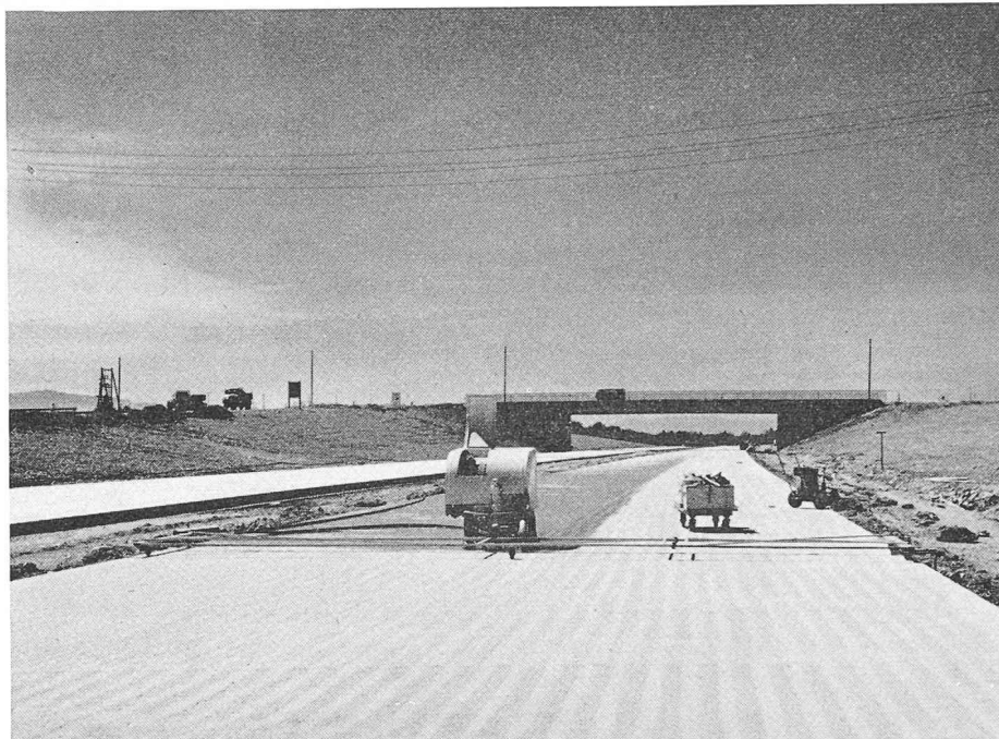
Fig. 2. — Sciage du joint longitudinal.
