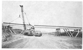
Fig. 5. — Mise en place des poutres.
