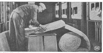
ULTRALITE matelas isolant à longues fibres incombustible, résistant à toutes secousses
