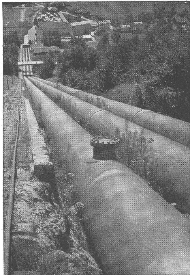
Enduit de protection à base de poudre de zinc après décapage au jet de sable et adapté au paysage à l'aide d'INERTOL 82 gris-vert.
