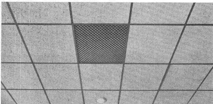
ULTRACOUSTIC dalle acoustique non perforée, incombustible, ici posée, sur rails visibles
