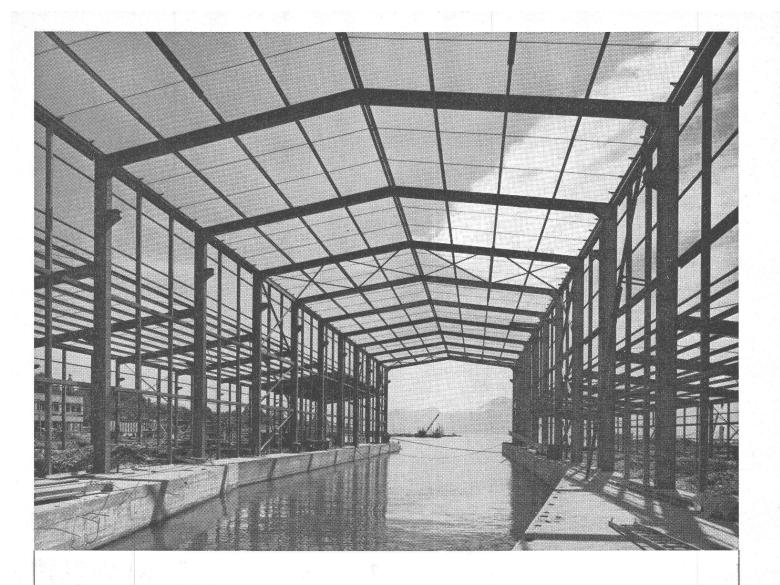
Ossature métallique de la nouvelle halle du bassin de Radoub de la C.G.N. à Lausanne. Largeur totale 40 m. Hauteur maximum 14 m. Poids total environ 300 t.
