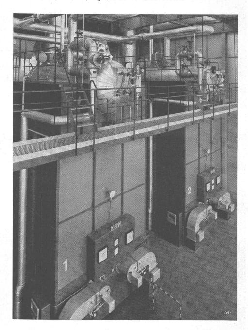
Deux chaudières à rayonnement type C, puissance unitaire 6,4 millions de kcal/h, pression de service 13 kg/cm², avec conduite principale et conduites pour la vapeur et l'eau d'alimentation. Les deux chaudières sont chauffées au mazout et celle de gauche est équipée en outre d'un foyer pour la combustion de déchets.
