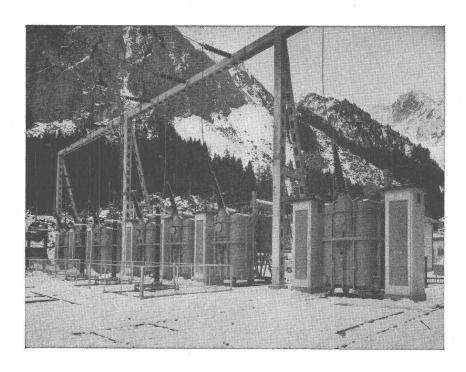
Sept des dix transformateurs monophasés formant deux groupes triphasés de 60 000 kVA, 10,5/250 kVA  $\pm$ 5 %, installés à l'usine de Fionnay des Forces Motrices de Mauvoisin S.A.
