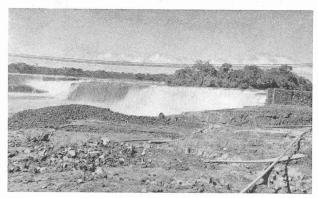
Fig. 6. — Batardeau en cours de construction.
