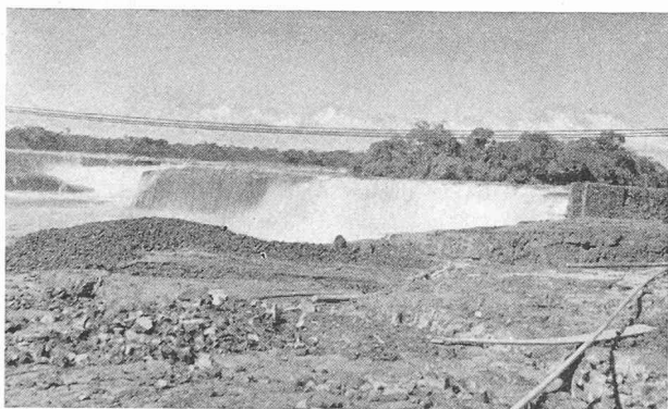
Fig. 6. — Batardeau en cours de construction.
