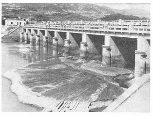
Fig. 4. — Barrage de Kerkini. Dépôts argilo-sableux à l'emplacement des renards après l'obturation des fuites en amont.
