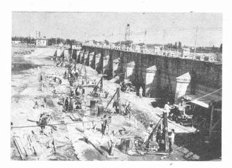
Fig. 5. — Barrage de Kerkini. Travaux de consolidation et imperméabilisation du terrain de fondation effectués en amont du barrage par la Société Fondedille.
