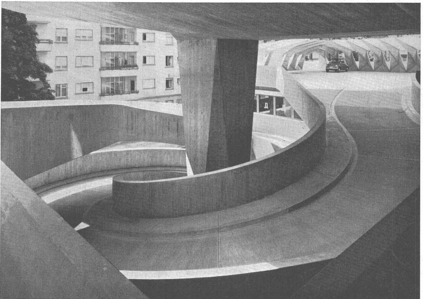
Rampe d'accès de la maison-tour « zur Palme » à Zurich. Chape en béton dur Korodur, exécutée par l'entreprise Heinr. Hatt-Haller S. A. à Zurich.
