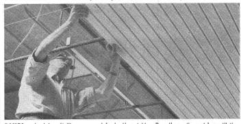
lambris métalliques pour plafonds démontables. Pour l'acoustique et la ventilation
