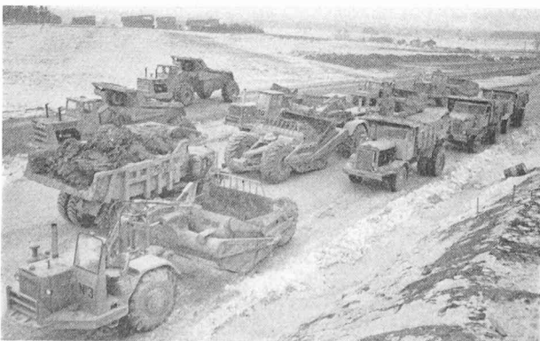
Fig. 3. — Une partie du parc de machines affectées aux gros terrassements ; la tranche de travaux la plus mécanisée.
