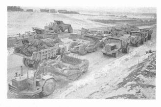
Fig. 3. — Une partie du parc de machines affectées aux gros terrassements ; la tranche de travaux la plus mécanisée.
