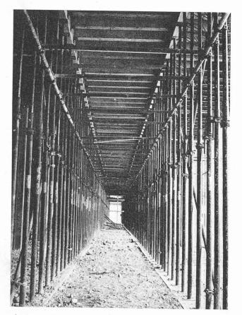
Fig. 4. — Travée de coffrage, composée d'unités d'étais préassemblées. On remarque l'alignement impeccable des étais ACROW, ce qu'une mise en place individuelle ne permet pas d'atteindre.
