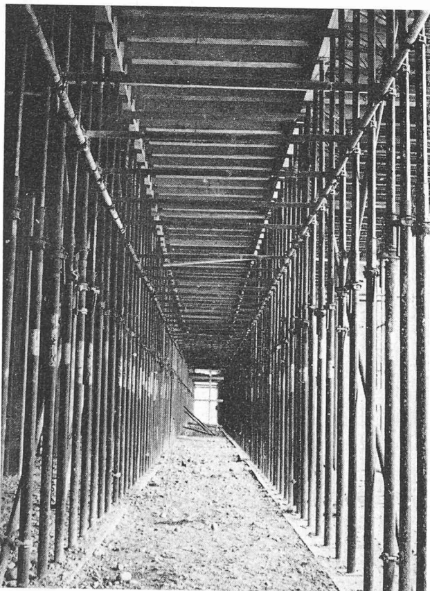
Fig. 4. — Travée de coffrage, composée d'unités d'étais pré-assemblées. On remarque l'alignement impeccable des étais ACROW, ce qu'une mise en place individuelle ne permet pas d'atteindre.
