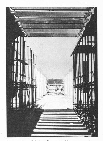
Fig. 2. — Les unités de coffrage en position. Chantier Ed. Dubied & Cie S.A., Marin.
