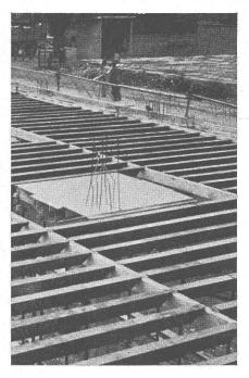
Pour coffrage de dalles tout à fait plane Langues d'appui rétractables Dessus très large Réglage facile Robuste
