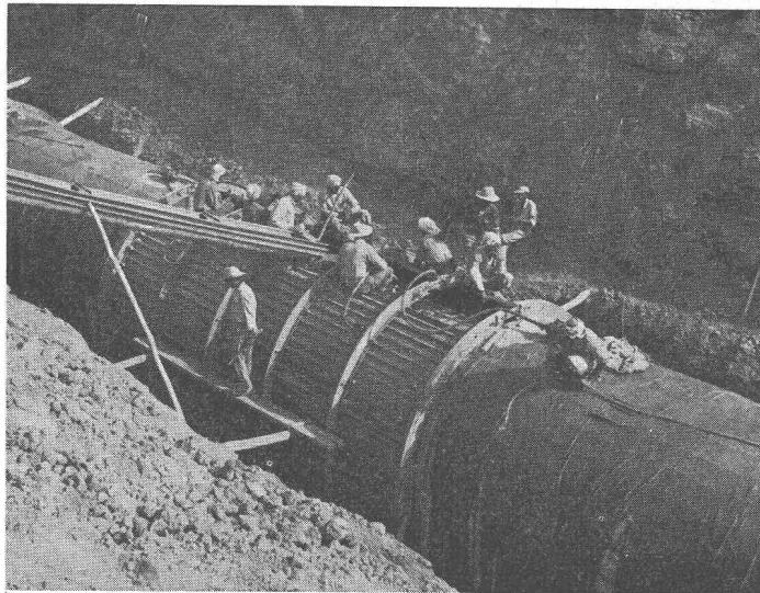
Eléments extérieurs et intérieurs d'un coffrage télescopique pour le réseau de canalisation de la ville de Bagdad.
