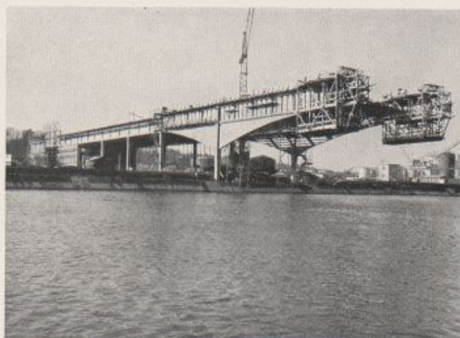
Fig. 16. — Construction d'une halle de transbordement dans le port d'Au près de Bâle. Procédé de montage par encorbellement
