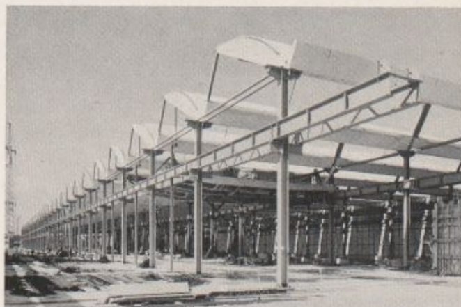
Fig. 17. — Halle de fabrication de la S.A. Brown Boveri & Cie à Birrfeld. Coques de shed préfabriquées sur construction métallique
