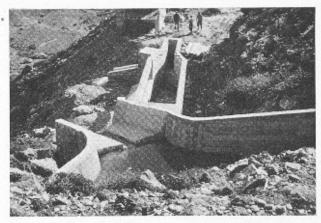
Fig. 6. - Prisc de Drône en cours d'exécution.
