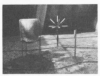
Fig. 1. — Bâti de fixation des sondes de mesure des déformations internes et de la température du bêton. A gauche, dans un récipient poreux, l'échantillon-témoin.
